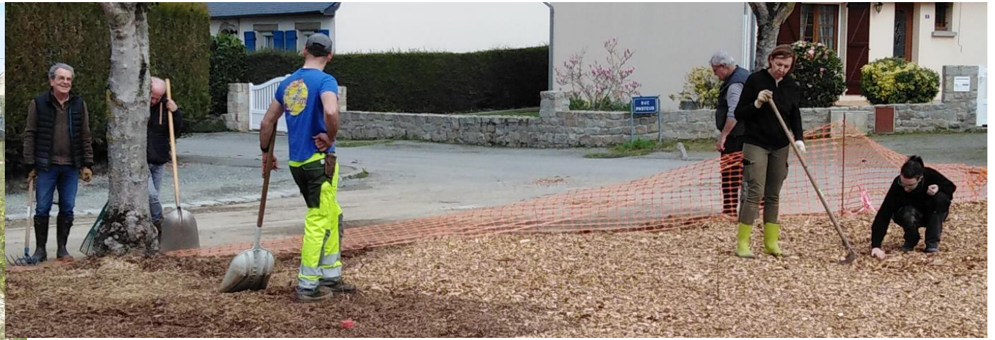
Chantier de plantation Elus – agents Le Minihic-sur-Rance - 2022
