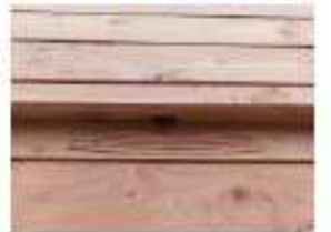
Gîtes à chiroptères Intégrés dans le bâti (8 gîtes au total)
