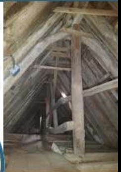
Intérieur de combles de l'Église de Gennes avec sa charpente du 16ème siècle (22)
