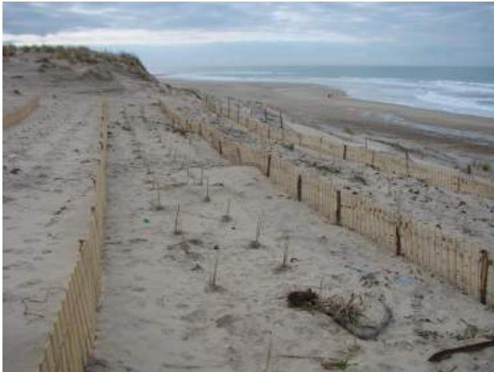
Brises vents de type ganivelle. © L GOUGUET-ONF
