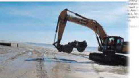
Après travaux, le sable pourra à nouveau circuler entre les épis.
