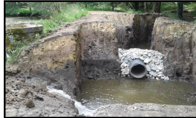
Les bassins filtrants
